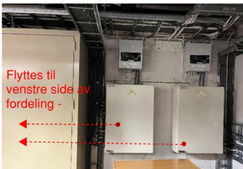
Figur 18: Flytting av tavler ved ny gjennomføring mot trapp
