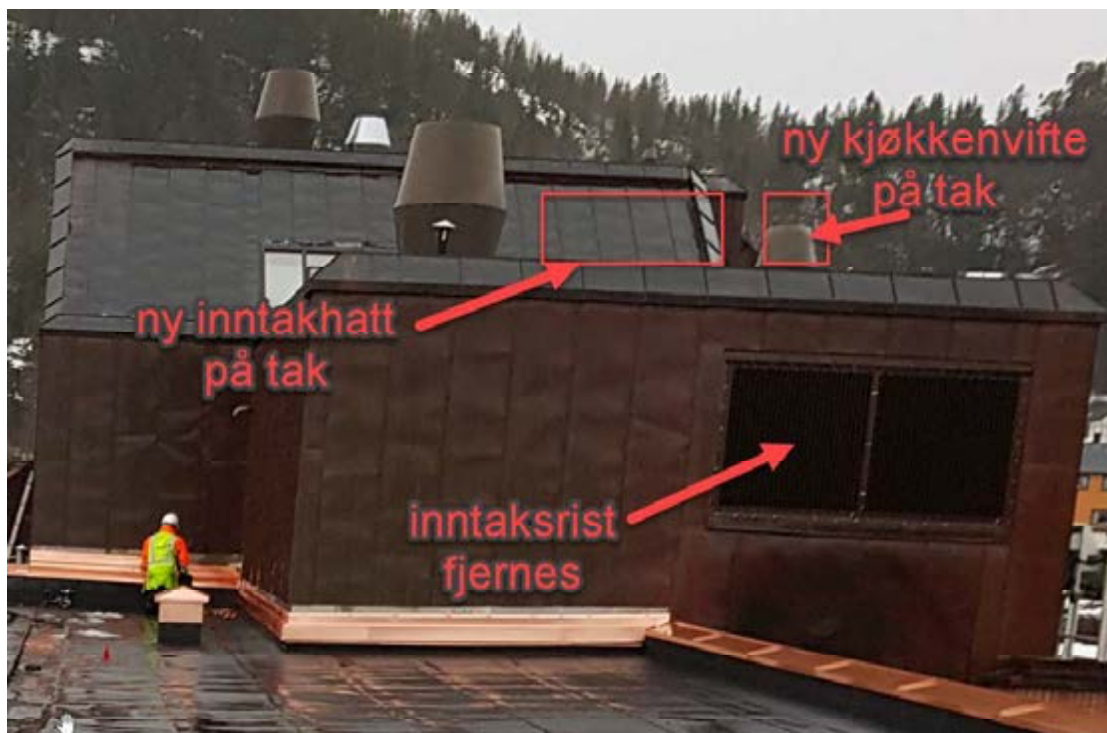
Figur 11: Tiltak 36.1 og 36.2 Inntaksrist fjernes og det etableres nytt luftinntak og avtrekksvifte tak.
