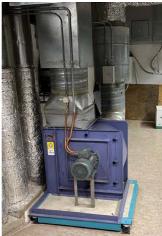
Figur 10: Tiltak 36.2 Kjøkkenavtrekk bygges om fra innvendig kanalvifte til takvifte
