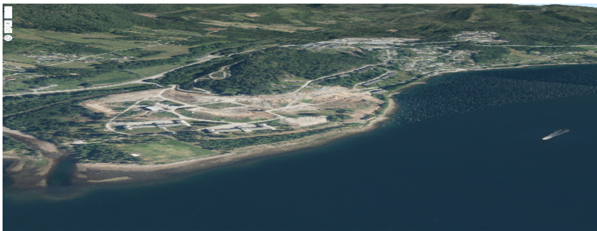
Figur 2 Oversiktsbilde over sykehustomta på Hjelset
